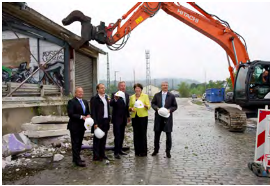
Erster Baggerbiss für das neue Geschäftsgebäude in der Bruchsaler Bahnstadt, in dem künftig Dienststellen des Landratsamts Platz finden.
