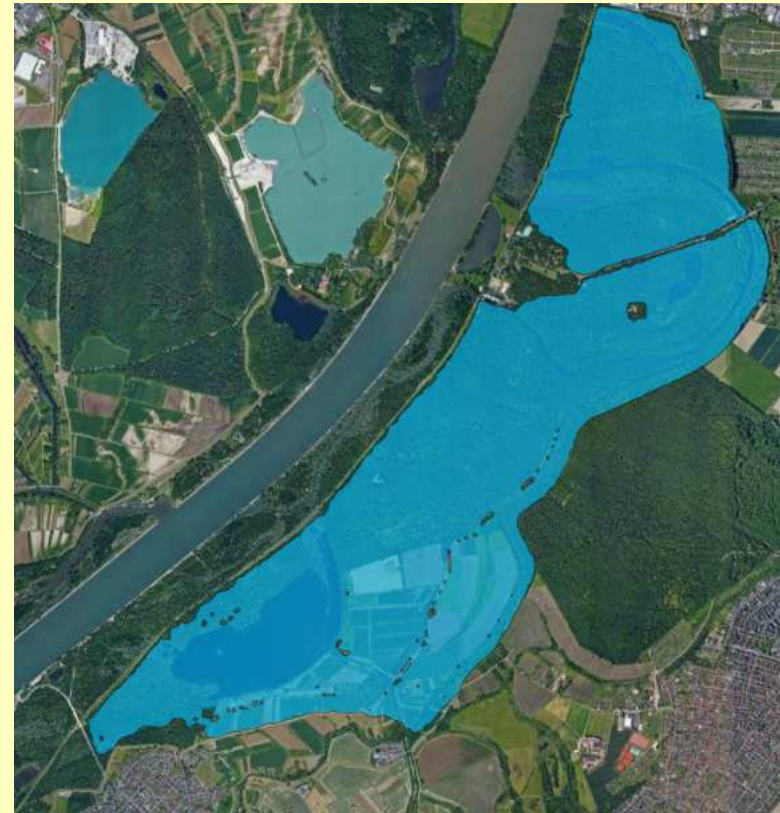
Abfluss: ca. 4.000 m 3 /s (interpoliert)
