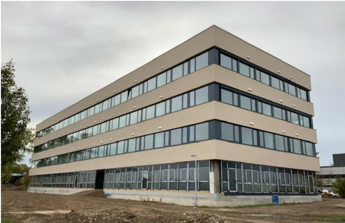
Gemeinschaftsunterkunft Östringen, Industriestraße 1
