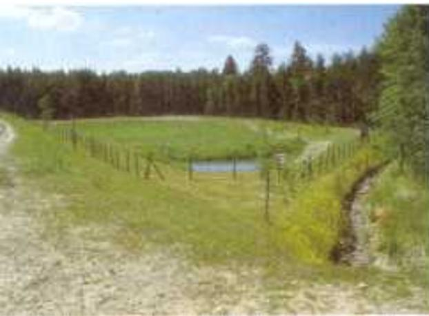
**Retentionsbodenfilter** werden für die Regenwasserbehandlung eingesetzt. Es handelt sich um Multifunktionsbauwerke, die neben einer qualitativen Reinigung auch einen quantitativen Rückhalt gewährleisten können.
