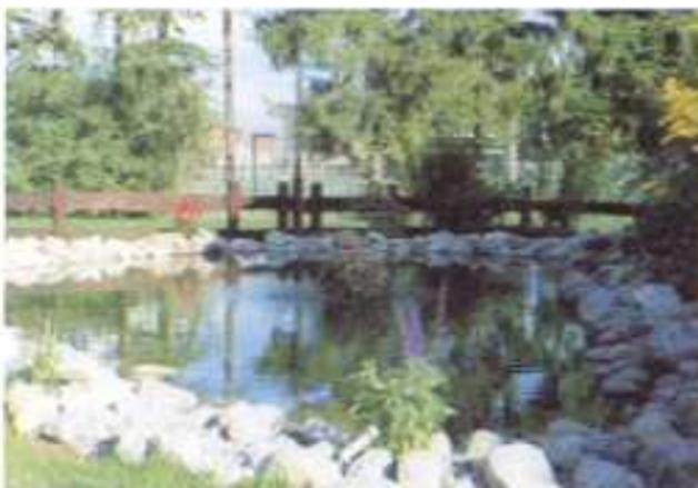
Bei der **Retentionsraumversickerung** wird das Regenwasser einem abgedichteten Teich, Feuchtbiotop oder Graben zugeleitet, dort eingespeichert und erst bei hohen Wasserständen über eine angeordnete Versickerungsfläche oder über offene Böschungsfächen dem Untergrund zugeführt.
