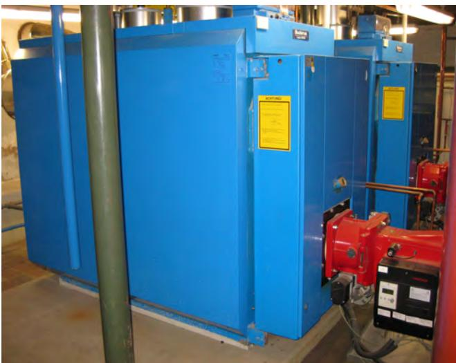
Die Heizzentrale dieses Objektes wurde im Jahr 2006 mit zwei neuen **Niedertemperaturgaskessel (siehe Bilder)** ausgestattet. Die Einzelraumregelung für die Lehrsäle wurde stillgelegt. Für die Heizkreise in der Zentrale (Lehrsäle, Flure, Fernleitung Neubau und Werkstattgebäude) wurde eine neue DDC-Regelung eingebaut. Weiterhin wurde die Kesselsteuerung auf der neuen Regelung aufgeschaltet.
