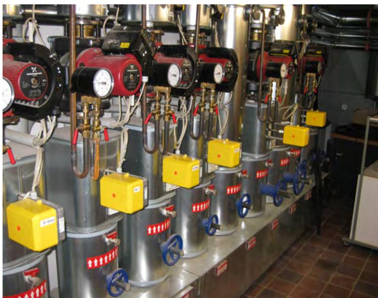
Die einzelnen Heizkreise wurden mit energieeffizienten, **drehzahl-geregelten Pumpen (siehe Bild)** ausgestattet. Mittelfristig ist eine Erneuerung der bislang unsanier-ten RLT-Anlagen (Zuluft) sowie dem Einbau von neuen frequenz-geregelten und direkt angetriebe-nen Ventilatoren incl. neuer Mess-, Steuer- und Regelungstechnik vorgesehen. Im Jahr 2018 erfolgt die Sanierung der Gebäudeleit-
