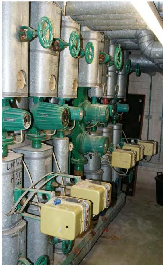
Das BBZ wird aus einer Zentrale mit zwei Heizkesseln (Gesamtleistung 2,6 MW) versorgt. Über Fernleitungen werden die einzelnen Unterverteilungen der weiteren Schulen bzw. die gemeinsam genutzten Gebäudeteile (Sporthalle, Werkstätten etc.) versorgt.
