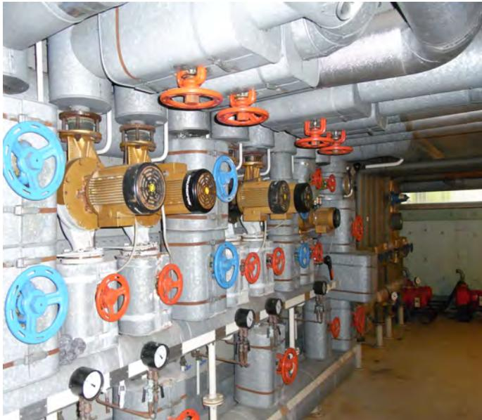
**Unterstationen** (*siehe Bild*) zu sanieren. Die hier verbauten ungeregelten Heizungspumpen sollten dringend gegen elektronisch geregelte Pumpen (drehzahlgeregelte Hocheffizienzpumpen) ersetzt werden. Die Sanierung der Unterstationen steht nicht im Zusammenhang mit einer etwaigen Umsetzung der Quartierskonzeption „Bruchsal Süd“. Hierbei geht es ausschließlich um die Erneuerung der abgängigen Wärmeerzeugung dieser Liegenschaft.
