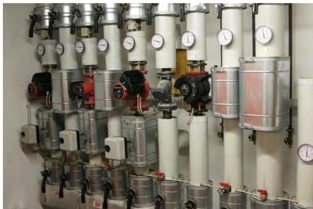
energieeffizienten, **drehzahlgeregelten Pumpen** (*siehe Bild*) ausgestattet. Die gesamten Anlagensteuerungen sind zentral auf einem Gebäudeleitstand aufgeschaltet.
