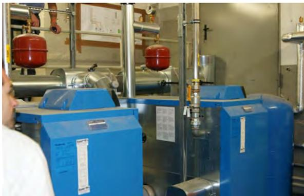
Die Heizungsanlage sowie die Schwimmbadtechnik wurden in 2007 saniert. Die Heizungsanlage wurde mit **Gasbrennwerttechnik (siehe Bild)** und energiesparenden Pumpen ausgestattet. Die Brauchwarmwasserversorgung wurde erneuert. Einzelne Warmwasserentnahmestellen, die aufgrund der geringen Wassermenge mit lokalen Klein-
