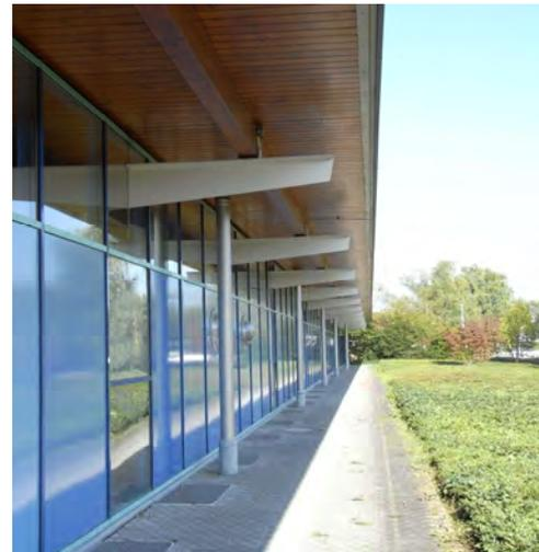
Glasfassade mit durchlaufenden Stahlträgern (Sporthalle)
