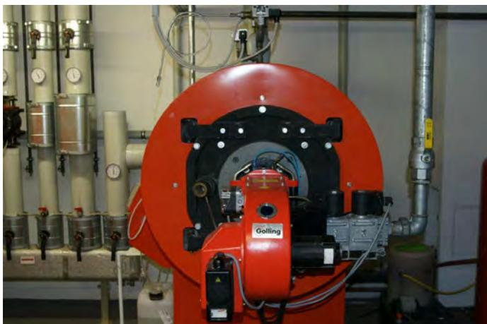
Die Heizzentrale (Kessel, Sammler, Pumpen, BWW Erzeugung und Regelung) der Astrid Lindgren Schule wurde saniert und ist in einem gutem Zustand. Ein **Heizkessel** (*siehe Bild*) versorgt die **Heizkreise** (*siehe Bild*) der Schule und den Brauchwarmwasserspeicher. Die einzelnen Heizkreise wurden mit
