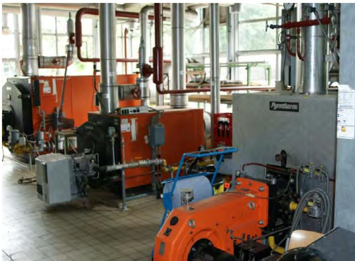
In der Heizzentrale des GBZ sind zwei BHKW's und drei **Heizkessel** (*siehe Bilder*) vorhanden, die die Unterverteilungen der Sporthalle, dem Schulgebäude und im Werkstattgebäude über Fernleitungen versorgen. Mittelfristig gilt es die Heizzentrale, die zugehörigen Nahwärmeleitungen auf dem Grundstück, wie auch die in den Gebäudeteilen befindlichen
