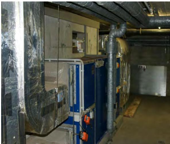
Der Energieverbrauch dieser Anlage ist aufgrund der schlechten Regelbarkeit sehr hoch. Mittelfristig sollte deshalb eine übergeordnete Regelungstechnik eingebaut und eine Aufschaltung zur Gebäudeleittechnik umgesetzt werden.
