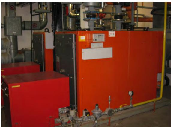
In der Heizzentrale der Ludwig Guttman Schule in Langensteinbach sind zwei **Heizkessel (siehe Bild)** installiert, die die Schule, das Schwimmbad und die Sporthalle (über eine Fernleitung) mit Wärme versorgen. Zur Erwärmung des Brauchwarmwassers wurde eine Solaranlage installiert, die überschüssige Wärme größtenteils im Sommer in das
