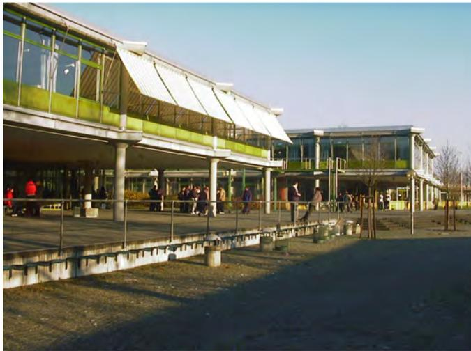
Tragkonstruktion Sichtbetonstütze als Wärmebrücke zum Innenraum (Schulgebäude)
