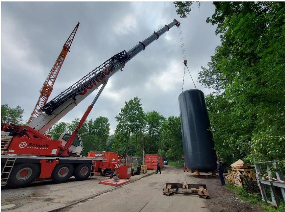
Abb.8: Anlieferung Wärmespeicher mit 100 m<sup>3</sup> Fassungsvermögen (KW 23)
