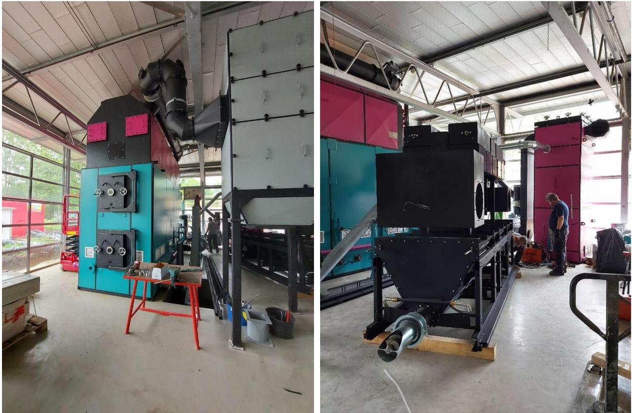
Abb.7: Biomassekessel und Elektrofilter (KW21-23)
