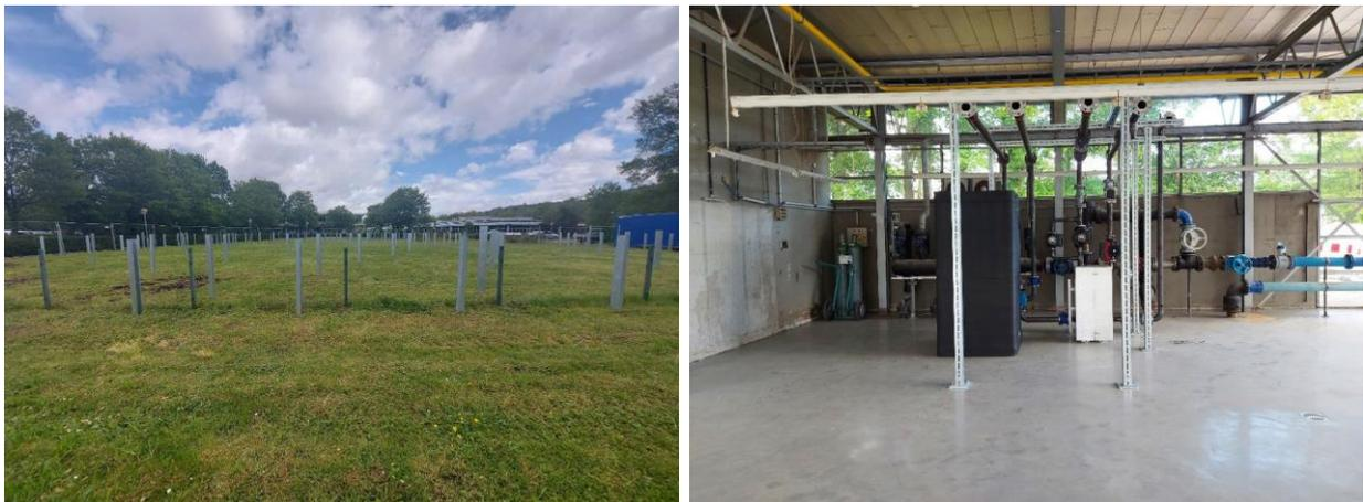
Abb.5: Stützen der Solarthermieanlage und Übergabestation (KW 18, 2021)
