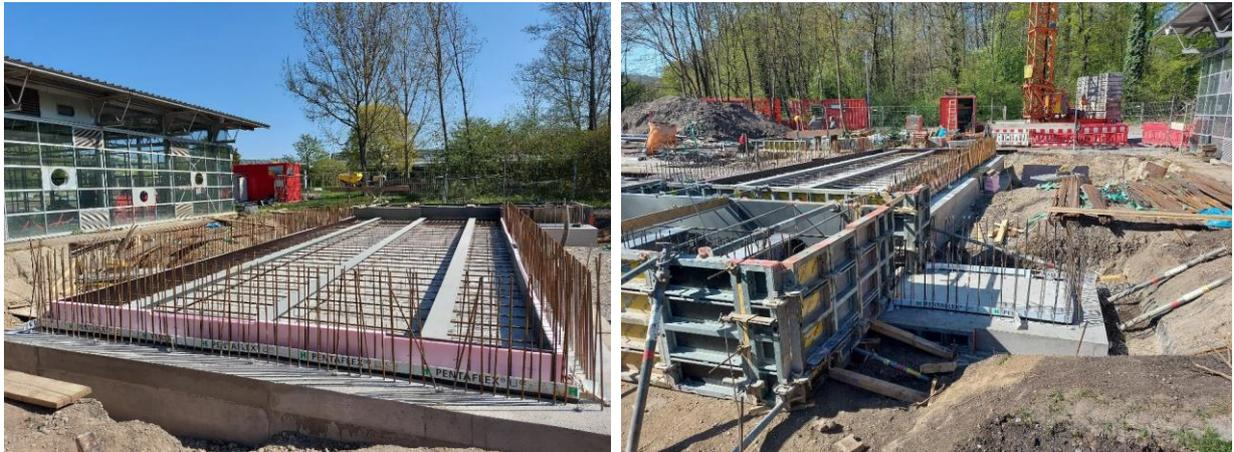
Abb.4: Bodenplatte mit Schubstangen des Hackschnitzelbunkers (KW 16, 2021)
