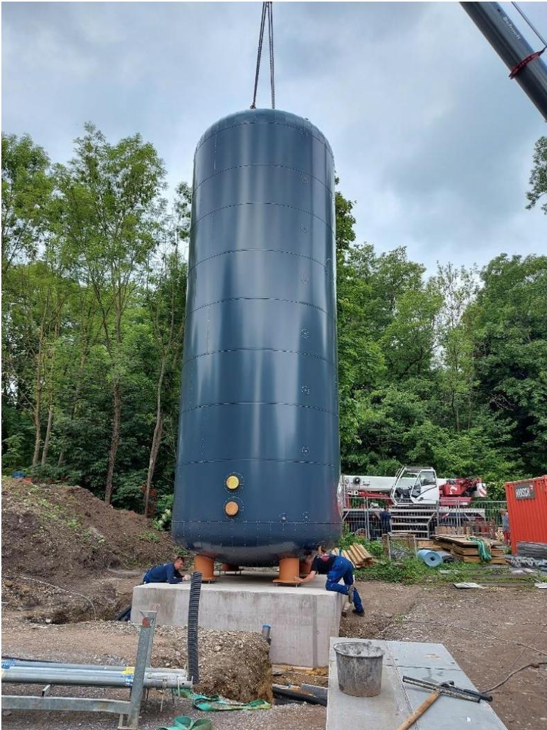
Abb.10: Montage Wärmespeicher mit 100 m<sup>3</sup> Fassungsvermögen (KW 23)
