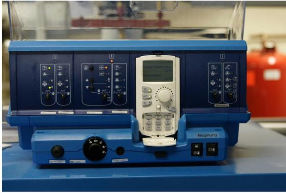
Gasbrenner erneuert. Die verbaute **Regelung (siehe Bild)** ermöglicht einen bedarfsgesteuerten Heizungsbetrieb. Gleichzeitig wurde die Brauchwarmwasserbereitung saniert und mit einer solarthermischen Anlage ausgestattet. Für den Heizbetrieb wurden energieeffiziente, drehzahlgeregelte Zirkulationspumpen eingebaut. Im Jahr 2008 wurde die Heizungsanlage
