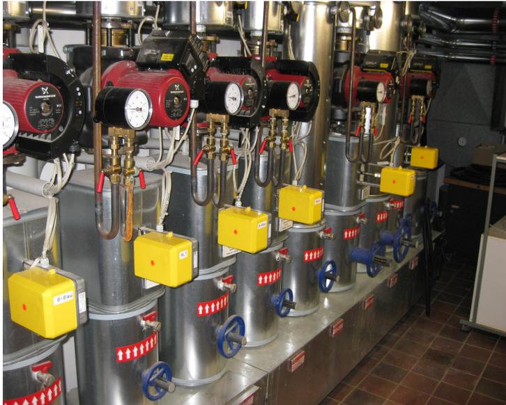
Die einzelnen Heizkreise wurden mit energieeffizienten, **drehzahl-geregelten Pumpen (siehe Bild)** ausgestattet. Mittelfristig ist eine Erneuerung der bislang unsanierten RLT-Anlagen (Zuluft) sowie dem Einbau von neuen frequenz-geregelten und direkt angetriebenen Ventilatoren incl. neuer Mess-, Steuer- und Regelungstechnik vorgesehen. Im Jahr 2018 erfolgt die Sanierung der Gebäudeleittechnik.
