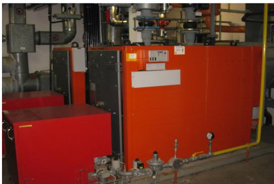
In der Heizzentrale der Ludwig Guttman Schule in Langensteinbach sind zwei **Heizkessel (siehe Bild)** installiert, die die Schule, das Schwimmbad und die Sporthalle (über eine Fernleitung) mit Wärme versorgen. Zur Erwärmung des Brauchwarmwassers wurde eine Solaranlage installiert, die im Sommer die überschüssige Wärme auch
