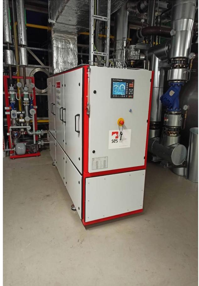
Abbildung: Hackschnitzelkessel und Biogas-BHKW des neuen Fernwärmenetzes „Bruchsal Süd“
