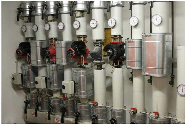
energieeffizienten, **drehzahlgeregelten Pumpen (siehe Bild)** ausgestattet. Die gesamten Anlagensteuerungen sind zentral auf einem Gebäudeleitstand aufgeschaltet. Aktuell befindet man sich in der Planung einer Quartierslösung zur Nahwärmeversorgung in Forst.
