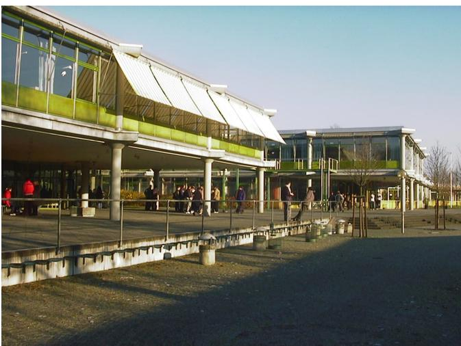
Tragkonstruktion Sichtbetonstütze als Wärmebrücke zum Innenraum (Schulgebäude)
