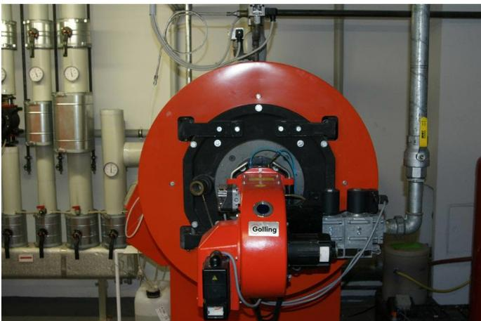
Die Heizzentrale (Kessel, Sammler, Pumpen, BWW Erzeugung und Regelung) der Astrid-Lindgren-Schule wurde saniert und ist in einem guten Zustand. Ein **Heizkessel (siehe Bild)** versorgt die **Heizkreise (siehe Bild)** der Schule und den Brauchwarmwasserspeicher. Die einzelnen Heizkreise wurden mit
