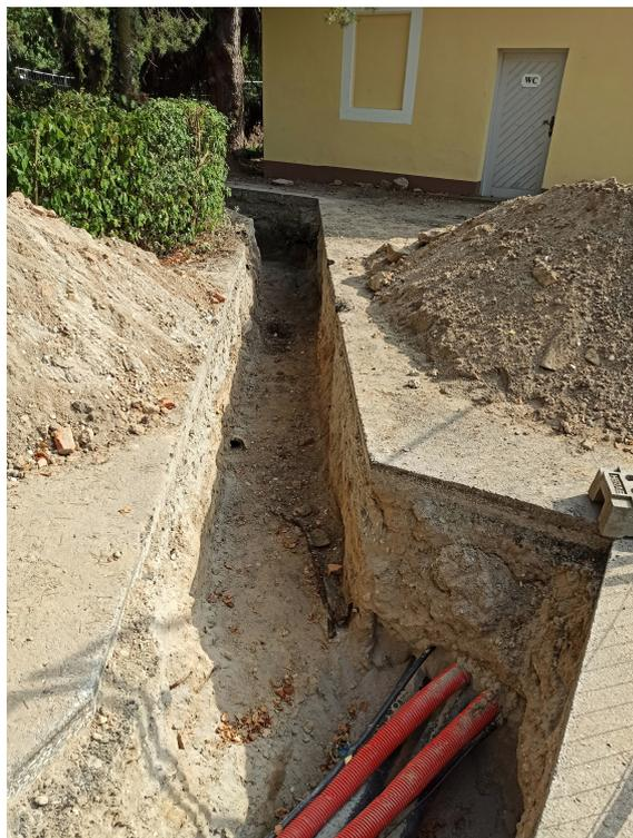
**Abb.:** Ausschachten zur Verlegung der Nahwärme- und Stromleitungen im erweiterten Versorgungsnetz der Jugendeinrichtung Schloss Stutensee.
