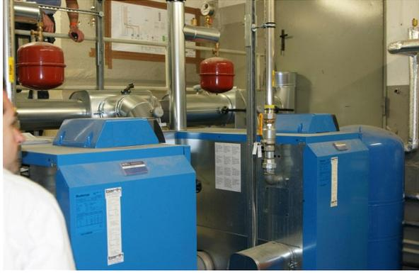
Die Heizungsanlage sowie die Schwimm- badtechnik wurden in 2007 saniert. Die Heizungsanlage wurde mit **Gasbrennwerttechnik (siehe Bild)** und energiesparenden Pumpen ausgestattet. Die Brauchwarmwasserversorgung wurde erneuert. Einzelne Warmwasserentnahmestellen, die aufgrund der geringen Wassermenge mit lokalen Kleinwarmwasserspeichern ausgerüstet worden sind, werden nun über ein Zeitschaltprogramm bedarfsgerecht gesteuert.
